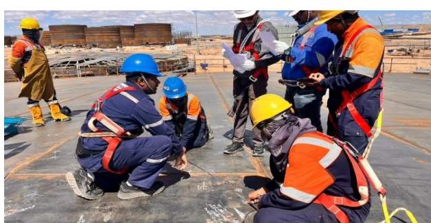
TF-03 вакуум газойл хадгалах савны дээврийн цоргыг гагнуурын өмнөх тааруулан угсрах (fit-up) ажил.
