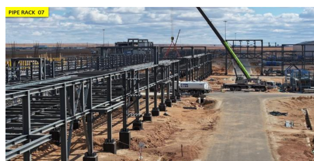
Pipe rack 07. Шугам хоолойн угсралтын ажил
