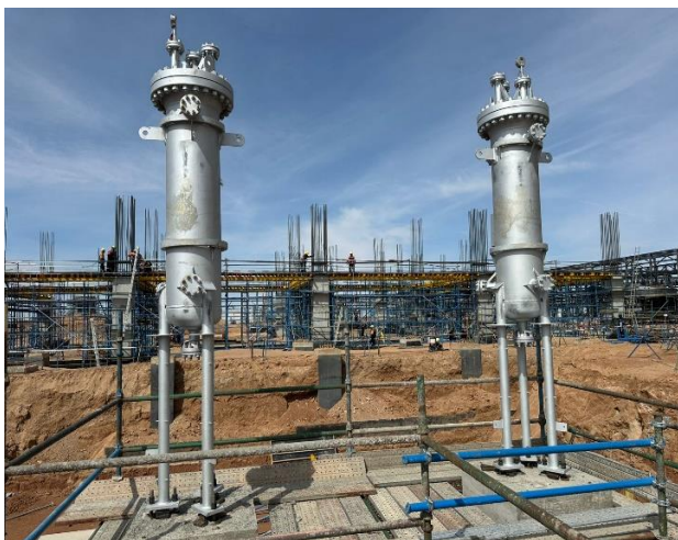
Хэрэглээний халуун усны системийн 211-V-1002A, 211-V-1002B суурилуулалт хийгдсэн.
