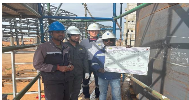
СРР-д байрлах түлш хадгалах савны их биеийн цоргоны байршлын тэмдэглэгээний ажил.
