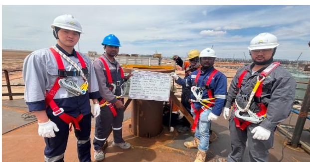
TF-03 вакуум газойл хадгалах савны дээврийн цоргыг гагнуурын өмнөх тааруулан угсрах (fit-up) ажил.
