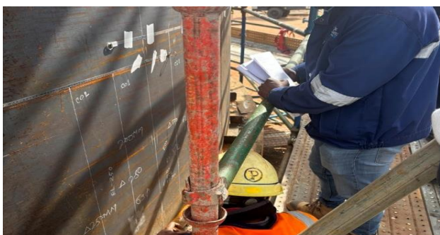
СРР-д байрлах түлш хадгалах савны их биеийн цоргоны байршлын тэмдэглэгээний ажил.
