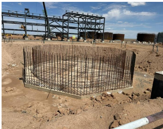
ҮДЦС-ийн Зуухны яндангийн суурийн бетон цутгалтын ажил хийгдсэн.
